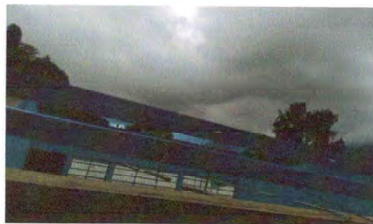
Foto 2: En esta gráfica se observa la estructura de techo del módulo ya sin las láminas de zinc.
