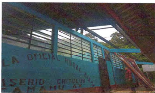
Foto 1: En la gráfica se observa el proceso de desinstalación de las láminas de zinc de la parte frontal de módulo 1.
