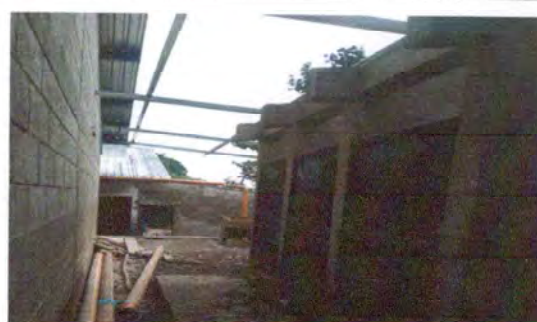
Foto 6: Módulo de la batería de baños siendo intervenida con trabajos de estructura de techo, cubierta de lámina y mantenimiento de puertas de metal.
