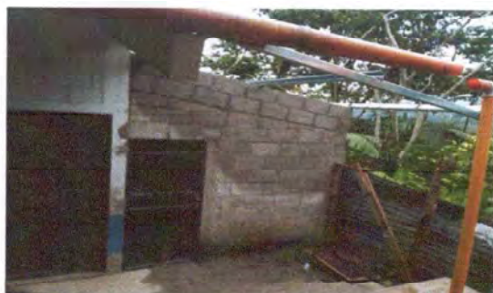
Foto 3: Módulo de cocina en el proceso de instalación de estructura de techo, para que posteriormente la instalación de cubierta de lámina.
