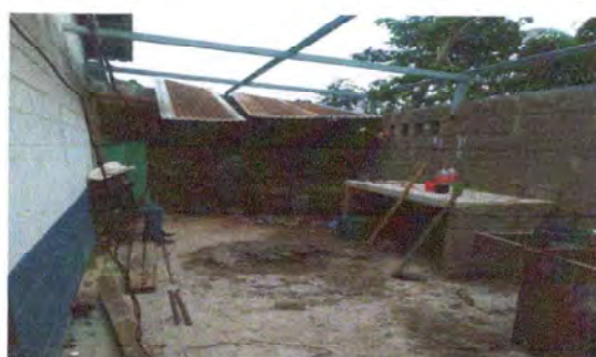
Foto 4: En la gráfica se observa los trabajos que se desarrollan en el área de cocina para mejorar su estructura.
